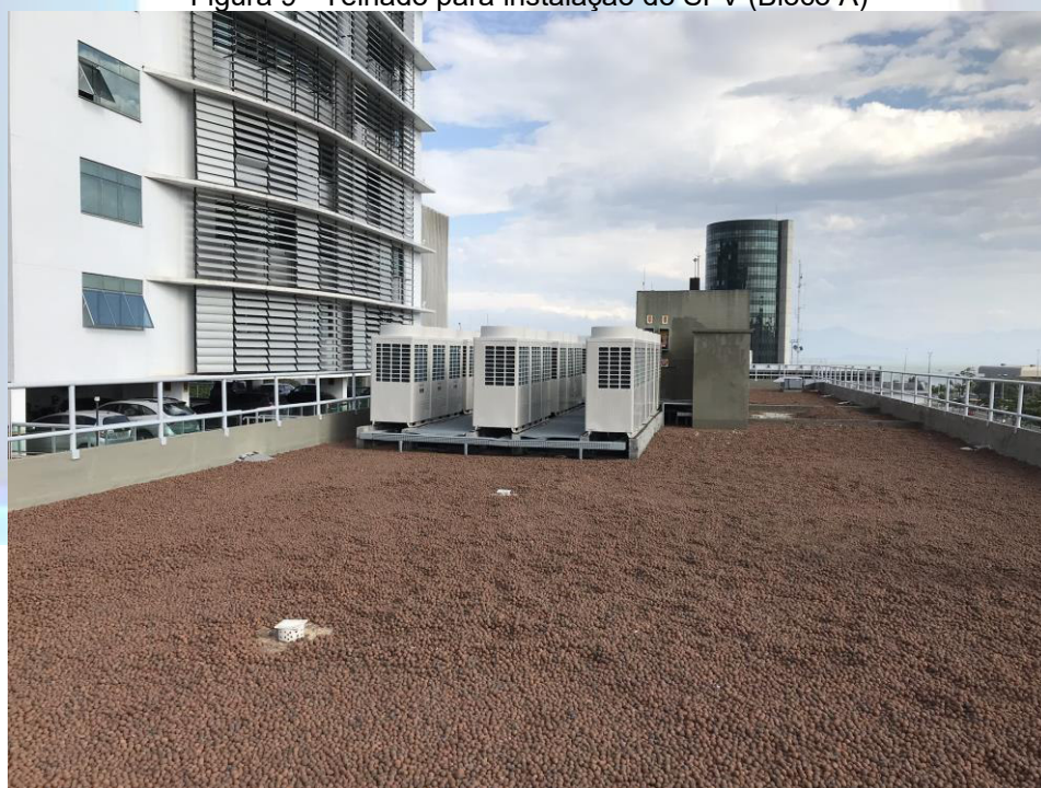
Figura 9 - Telhado para instalação do SFV (Bloco A)
