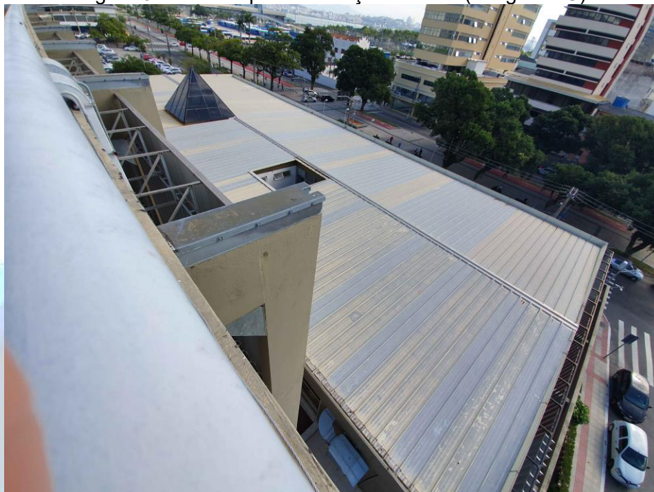
Figura 8 - Telhado para instalação do SFV (Antiga DMU)
