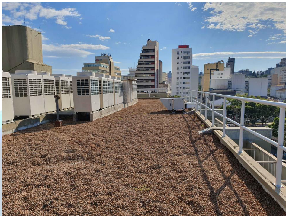
Figura 10 - Telhado para instalação do SFV (Bloco B)
