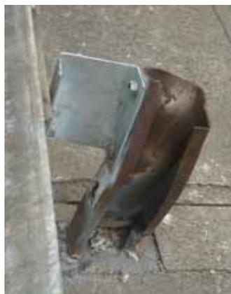
**LOCAL DO ACIDENTE:** Poste de sustentação da defesa metálica com manutenção inadequada
