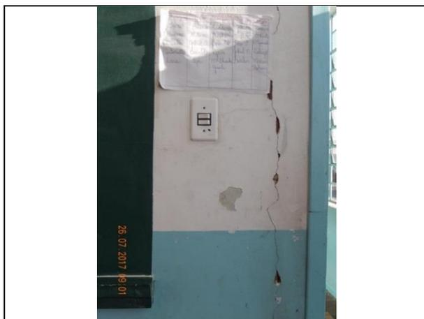
**Foto nº 7031 de 26/07/2017:** Sala de aula com parede trincada - EEB Vidal Ramos Júnior.
