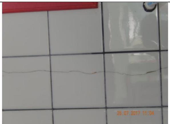
**Foto nº 6985 de 25/07/2017:** Banheiro com parede de cerâmica trincada - EEB Humberto Hermes Hoffmann.
