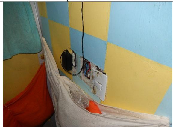
Imagem 3148 – Cela com fiação elétrica aparente.
