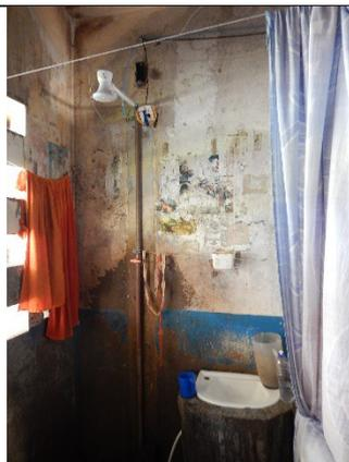
Imagem 3250 – Cella com fiação elétrica aparente e pintura da parede descascada.
