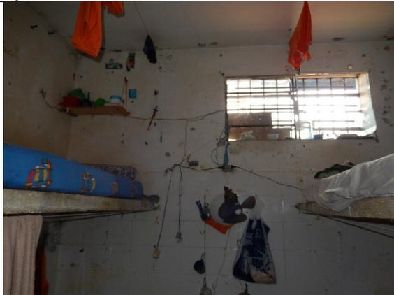
Imagem 2961 – Cella com fiação aparente e paredes mal conservadas.
