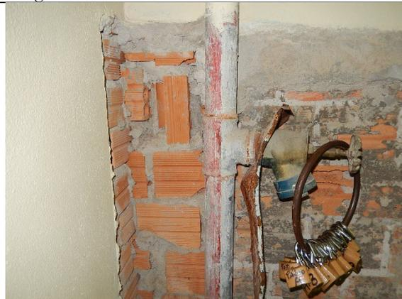
Imagem 3156 – Ausência do equipamento de combate a incêndio.
