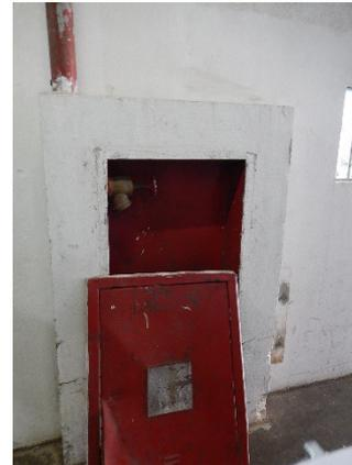
Imagem 3286 – Equipamento de combate a incêndio danificado.
