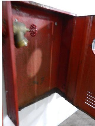
Imagem 3271 – Equipamento de combate a incêndio danificado.
