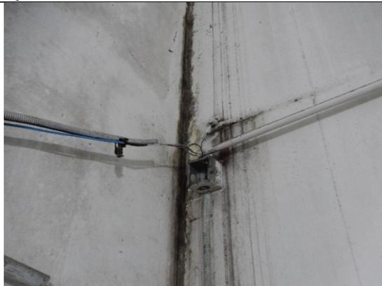
Imagem 3235 – Infiltração e fiação elétrica aparente na galeria.
