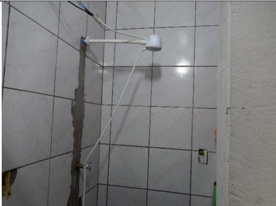
Imagem 3420 – Fiação elétrica aparente.
