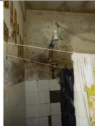
Imagem 2959 – Banheiro da cela sem azulejos e com umidade nas paredes.
