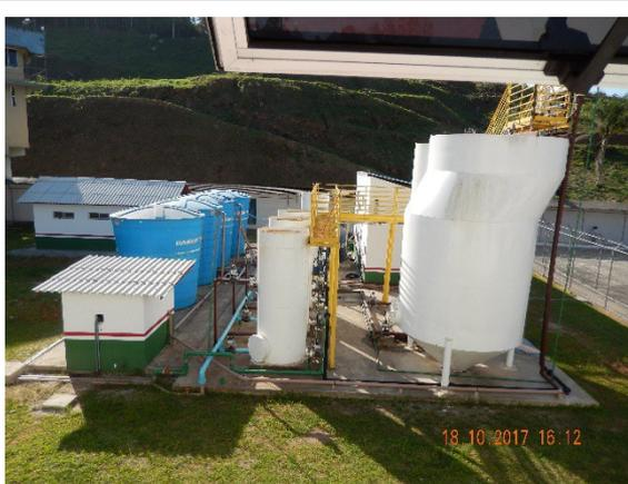
Imagem 7479 – Estação de tratamento de água, no COPE.
