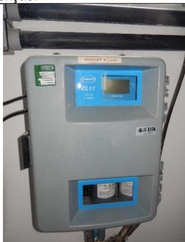
**Foto 3860 – 11/08/16:** Equipamentos – Analizador de cloro sem operar por falta de manutenção.
