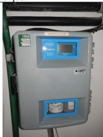
**Foto 3861 – 11/08/16:** Equipamentos – Analizador de flúor sem operar por falta de manutenção.
