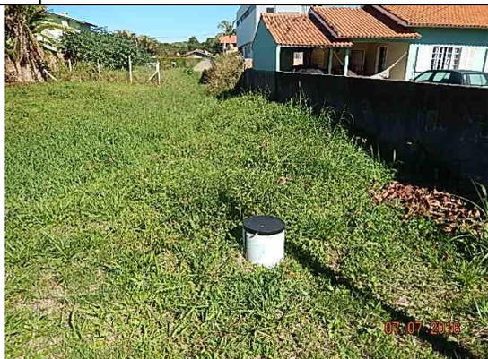
**Foto 2257:** Poço Coruja – lacrado por contaminação de esgoto.
