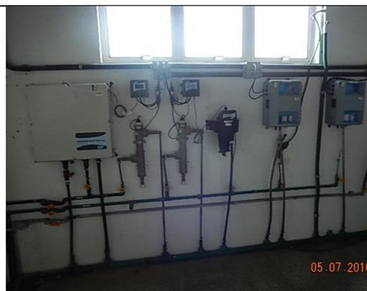
**Foto 2002 – 05/07/16:** Equipamentos de automação sem operar por falta de manutenção.
