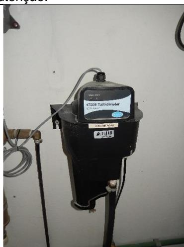
**Foto 3859 – 11/08/16:** Equipamentos – Turbidímetro sem operar por falta de manutenção.
