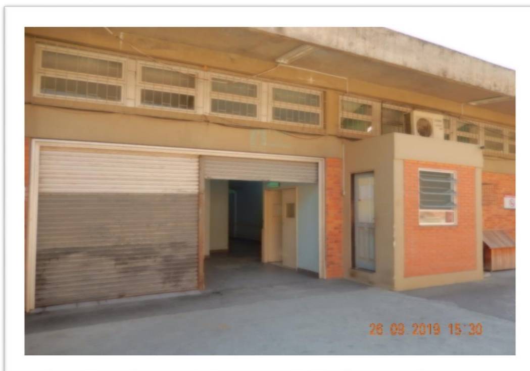
Figura 05: Porta que dá acesso ao almoxarifado localizado nos fundos do hospital.
