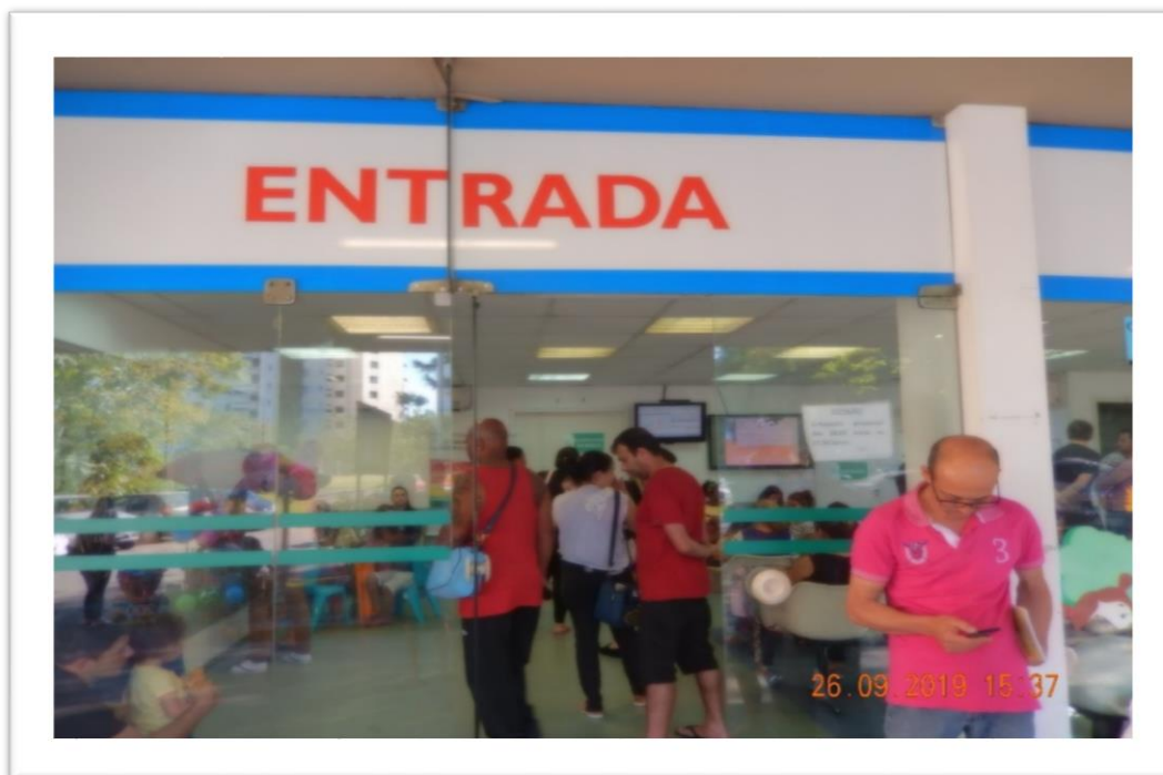
Figura 06: Entrada da Emergência, com apenas vigilante e câmera, sem barreiras físicas ou catracas
