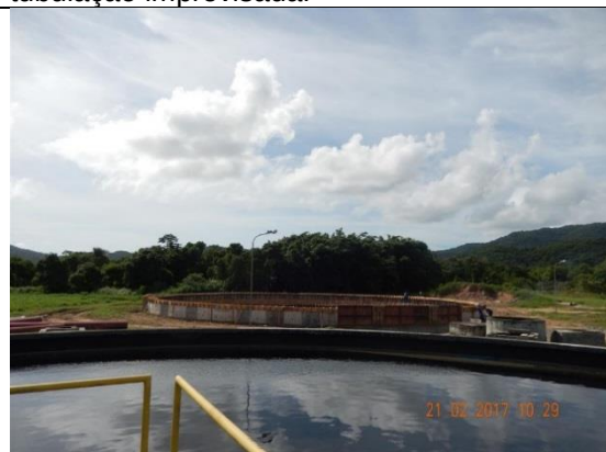
Foto nº 4596 de 21/02/17 – Decantador 3 em construção.
