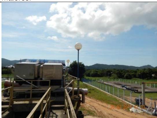
Foto nº 4506 de 20/02/17 – Duas grades do Aqua Guard, que retira os resíduos menores.
