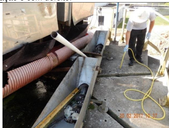
Foto nº 4469 de 20/02/17 – Operador limpando a tubulação improvisada dos resíduos que recebe do Aqua Guard.
