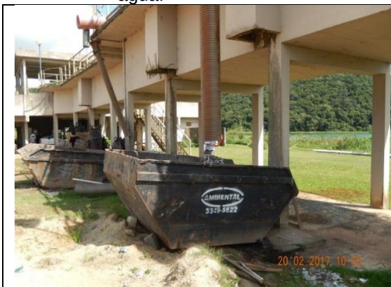
Foto nº 4495 de 20/02/17 – caçambas estacionárias que recebem o material grosseiro sem registro ou torneira para o vazamento do líquido percolado.
