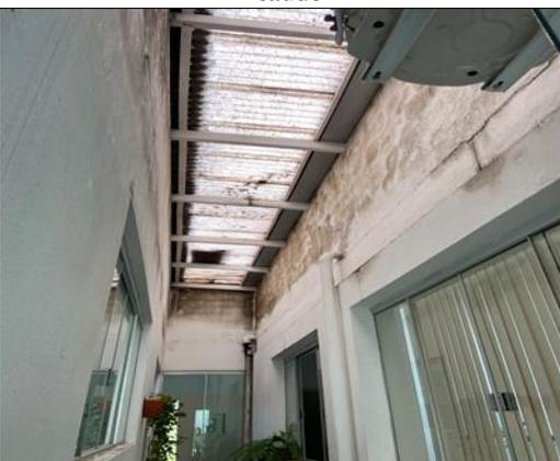
Poço de iluminação e ventilação com infiltração e mofo
