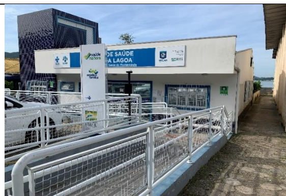
UBS Canto da Lagoa em 28/04/2022 – obras de ampliação de espaço
