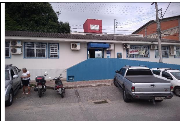
UBS Costeira do Pirajubaé em 27/03/2019 - fachada principal da Unidade
