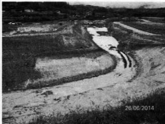
Foto 100\_6390: Canal extravasor em construção.
