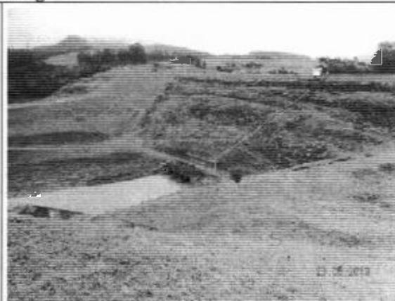
Foto DSCN1100: Talude de montante e tomada d'água, com entulhos e assoreada.
