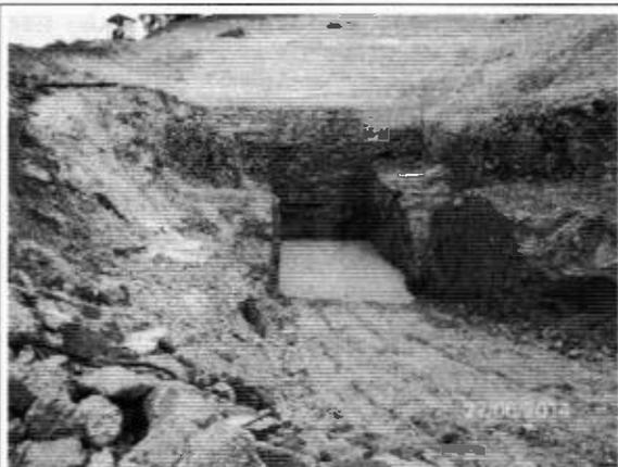
Foto 100\_8110: Entrada do canal extravasor lateral em construção.
