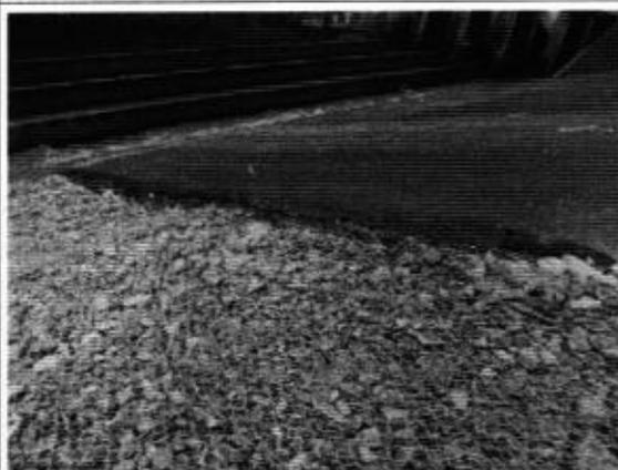
Foto DSCN1206: Trecho revestido com capa de concreto, mais resistente à ação dos vórtices.
