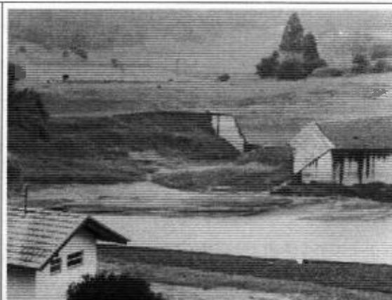
Foto DSCN1081: Erosão na saída do canal extravasor lateral.
