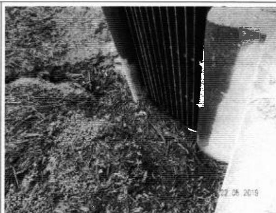
Foto DSCN1006: Assoreamento, madeira e entulhos na tomada d'água.
