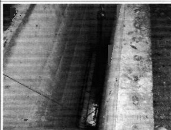
Foto DSCN1107: Comporta canal extravasor lateral (vista superior), atualmente com acionamento por guincho, que deveria servir apenas para manutenção da comporta.
