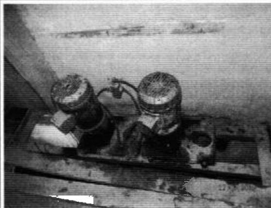
Foto DSCN1055: Bombas para esvaziamento da água percolada para dentro da galeria, com acionamento apenas manual.
