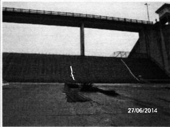
Foto 100\_8050: Obra de sobre-elevação no vertedouro.
