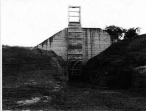
Foto DSCN1118: Entrada do canal extravasor lateral (vista frontal), com acionamento apenas por cabos (guincho).
