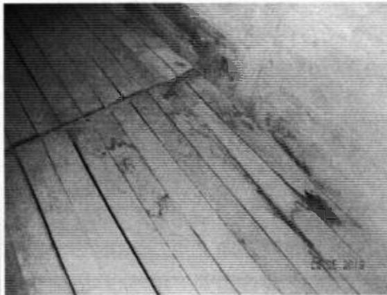
Foto DSCN1049: Tábuas de madeira soltas, algumas em deterioração, na galeria de inspeção.
