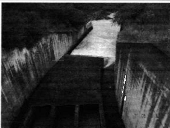
**Foto DSCN0896:** De acordo com o informado, ao longo do coroamento da barragem, havia postes de iluminação, que foram arrancados e furcados. Atualmente, é possível se identificar apenas os conduites elétricos.
