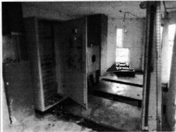
**Foto DSCN0861:** Sala de controle e operação, completamente vandalizada. O gerador foi furtado recentemente, os comandos hidráulicos e os controles, depredados. Havia forte odor de urina no local.
