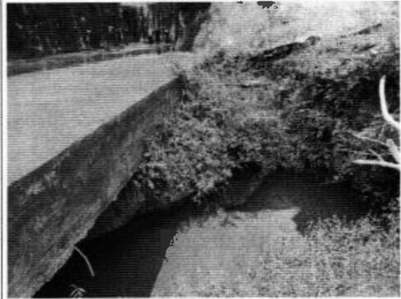
Foto DSCN1284: Erosão ao lado e abaixo da laje de concreto, na saída do canal extravasor lateral.
