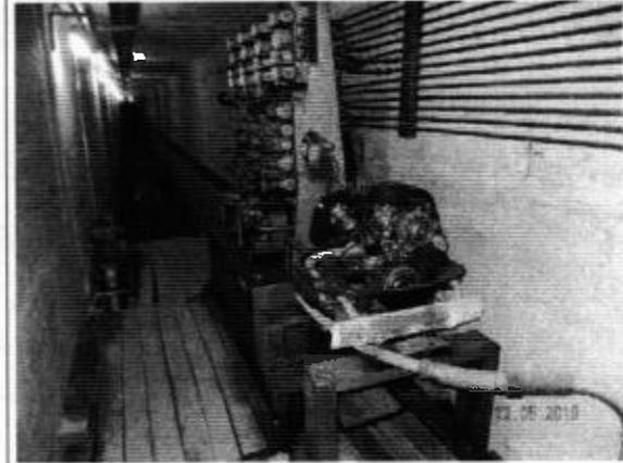
Foto DSCN1051: Equipamento de manobra das comportas na galeria de inspeção (piso inferior). Apesar de antigo, funciona satisfatoriamente, apesar da dificuldade de se encontrar peças de reposição, trazendo risco à continuidade da operação.
