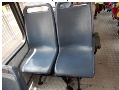
Foto DSCN7956 de 21/11/2022 – veículo terceirizado placa HRO 4B39 com banco do ônibus escolar sem cinto de segurança.
