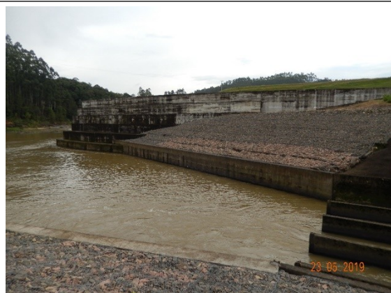
Foto DSCN1197: Muro executado, assim como colchões de gabião nas duas margens.
