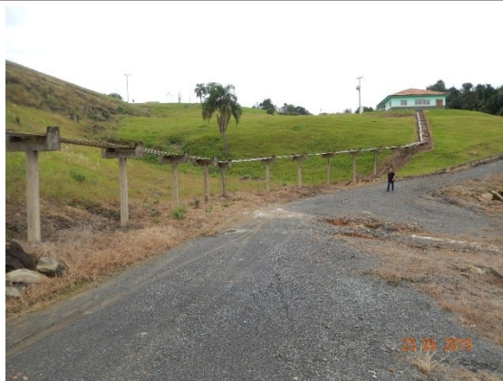
Foto DSCN1207: Talude de jusante.
