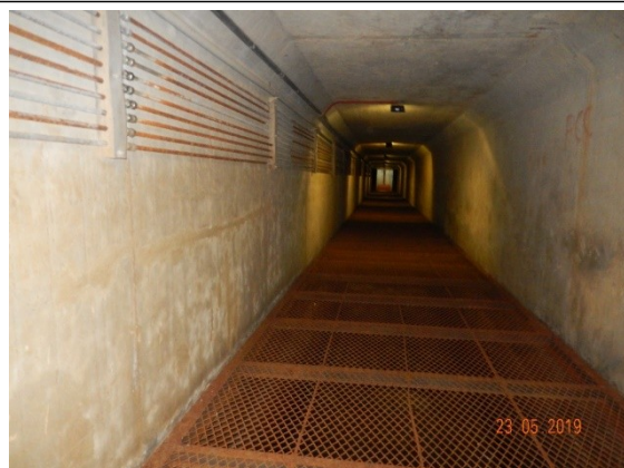
Foto DSCN1220: Galeria de inspeção.
