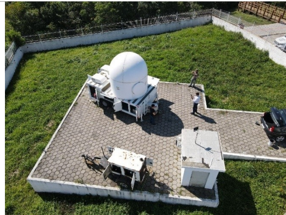
Fonte: imagem feita por drone no dia 17/08/2023 - DJI0409
