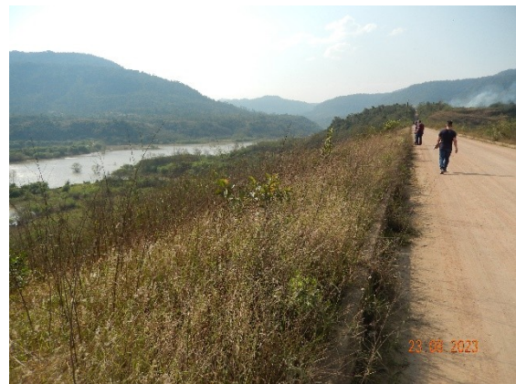
Foto DSCN3707: Coroamento.
