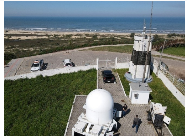
Fonte: imagem feita por drone no dia 17/08/2023 - DJI0405
