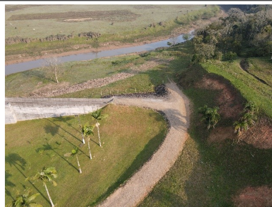
Foto DJI0624: Vista aérea da ombreira direita.
