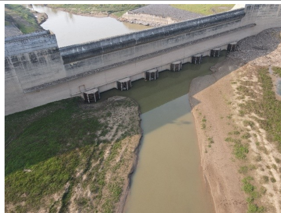
Foto DJI0626: Tomadas d'água. Nota-se o assoreamento do canal do rio e a Comporta 7 (à direita) com muito material à volta.
