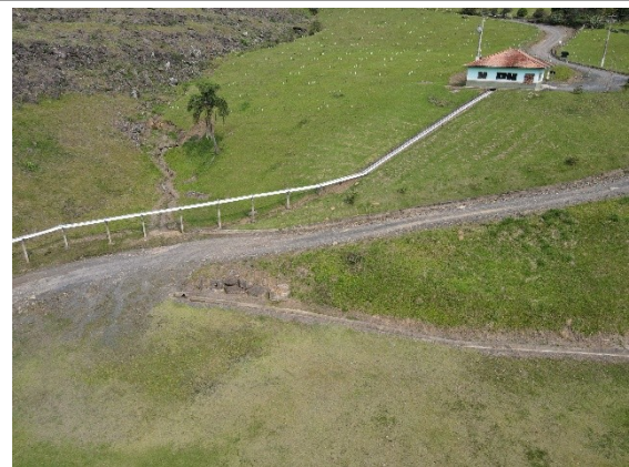
Foto DJI0735: Vista do talude de jusante.
