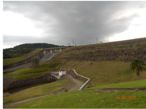
Foto DSCN4016: Taludes de jusante e vertedouro central sobre-elevado.
