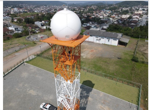
Fonte: imagem feita por drone no dia 22/08/2023 - DJI0431
