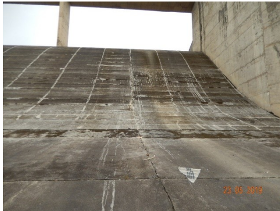
Foto DSCN1272: Vertedouro sobre-elevado.
