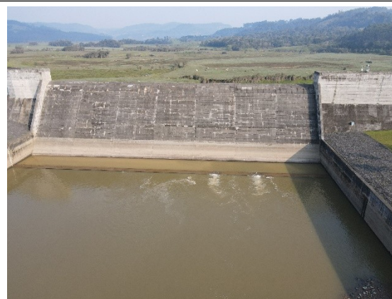
Foto DJI0622: Vista frontal a jusante do vertedouro.
