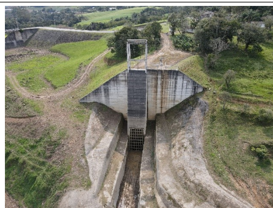
Foto DJI0682: Vista d parte a jusante. Entrada do canal extravasor lateral construído (vista frontal), ainda com acionamento apenas por cabos (guincho).
