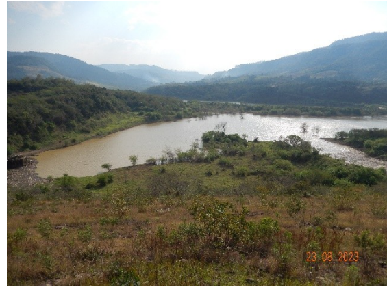
Foto DSCN3717: Talude de montante.
