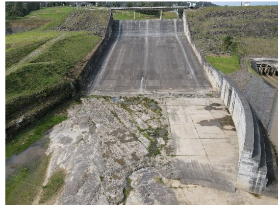
Foto DJI0721: Vista do vertedouro.
