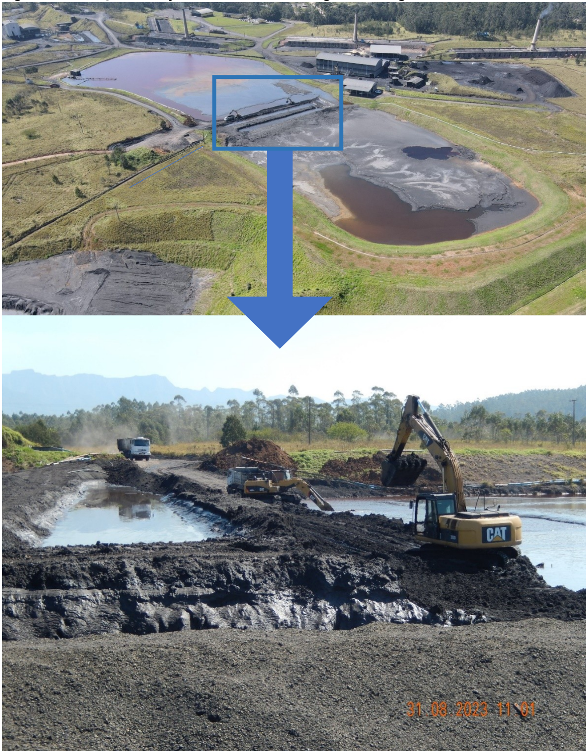
Figura 3 – Remoção dos rejeitos de dentro da barragem – vista geral e detalhe
