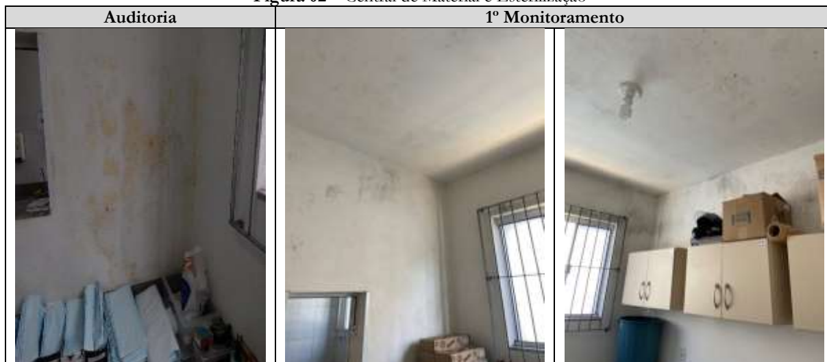
Figura 02 – Central de Material e Esterilização
