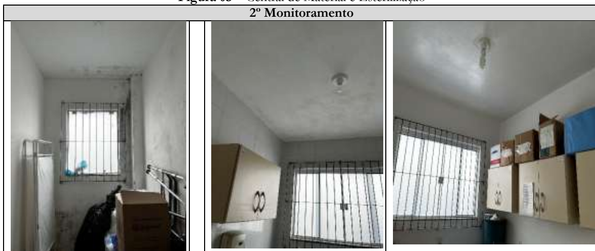
Figura 03 – Central de Material e Esterilização
