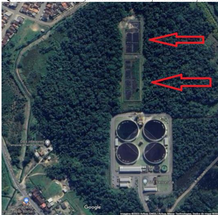
Quadro 15 – Nova ETE Jarivatuba com indicação da localização das bags nos taludes
