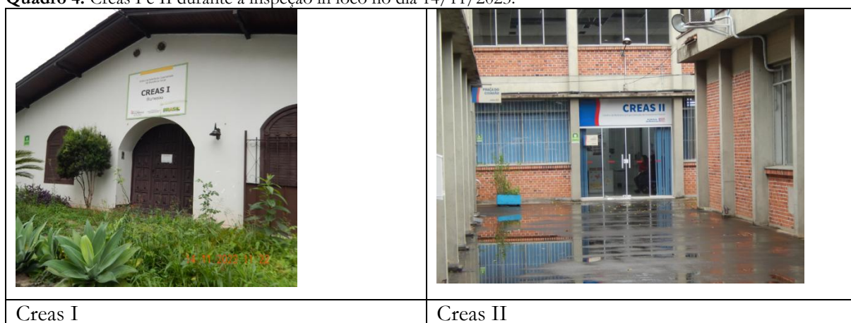
Quadro 4: Creas I e II durante a inspeção in loco no dia 14/11/2023.
