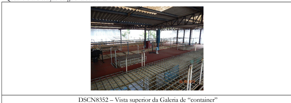
Quadro 34: Situação da galeria de container
