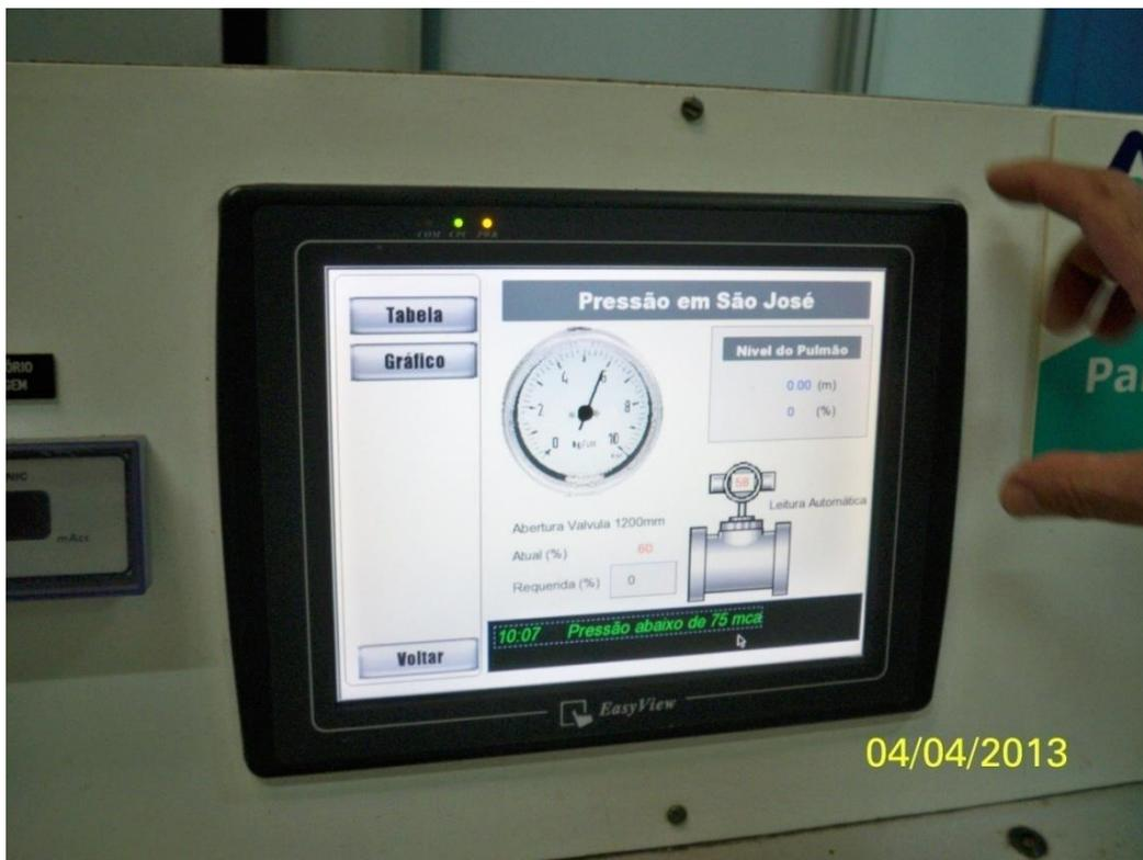
**Foto 6125:** Controle pressão identificando abertura da válvula da adutora de 1200 mm.
