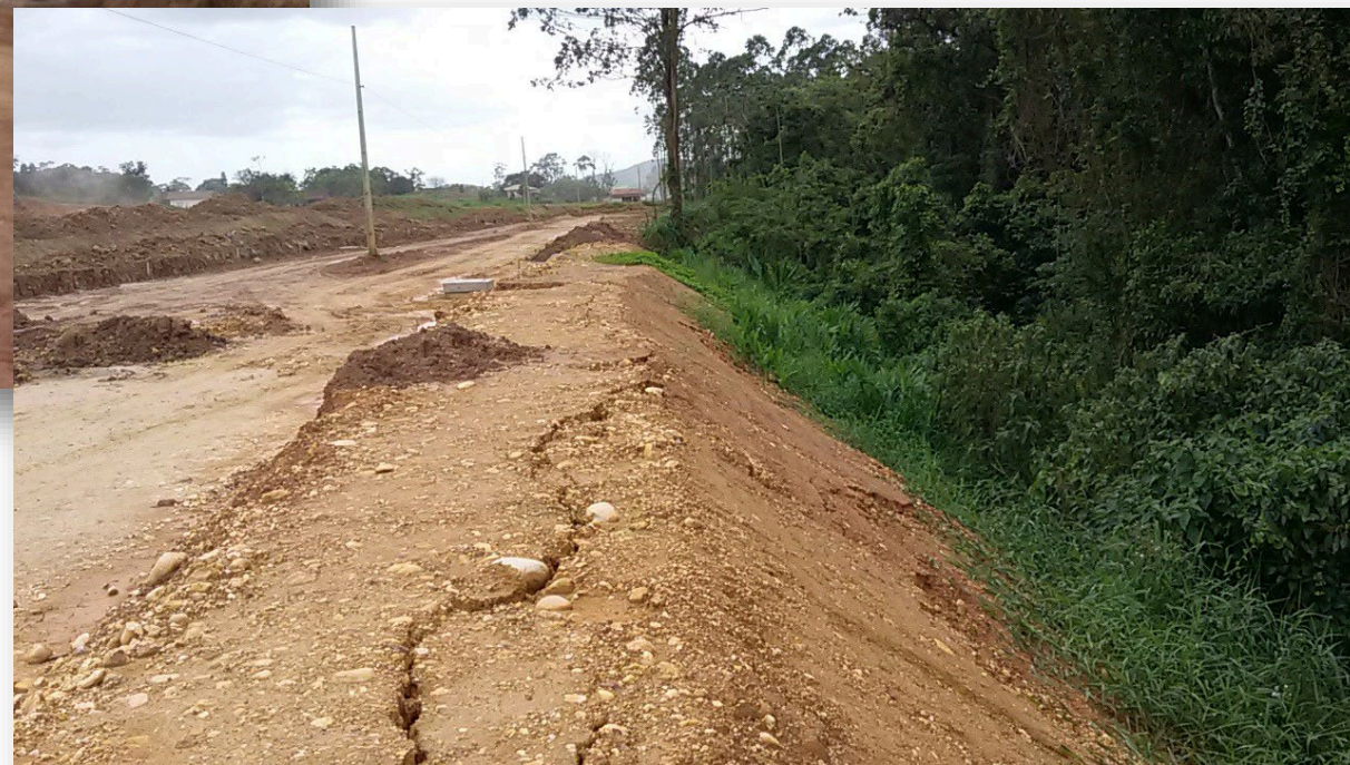
Talude sem revestimento - rompimento
