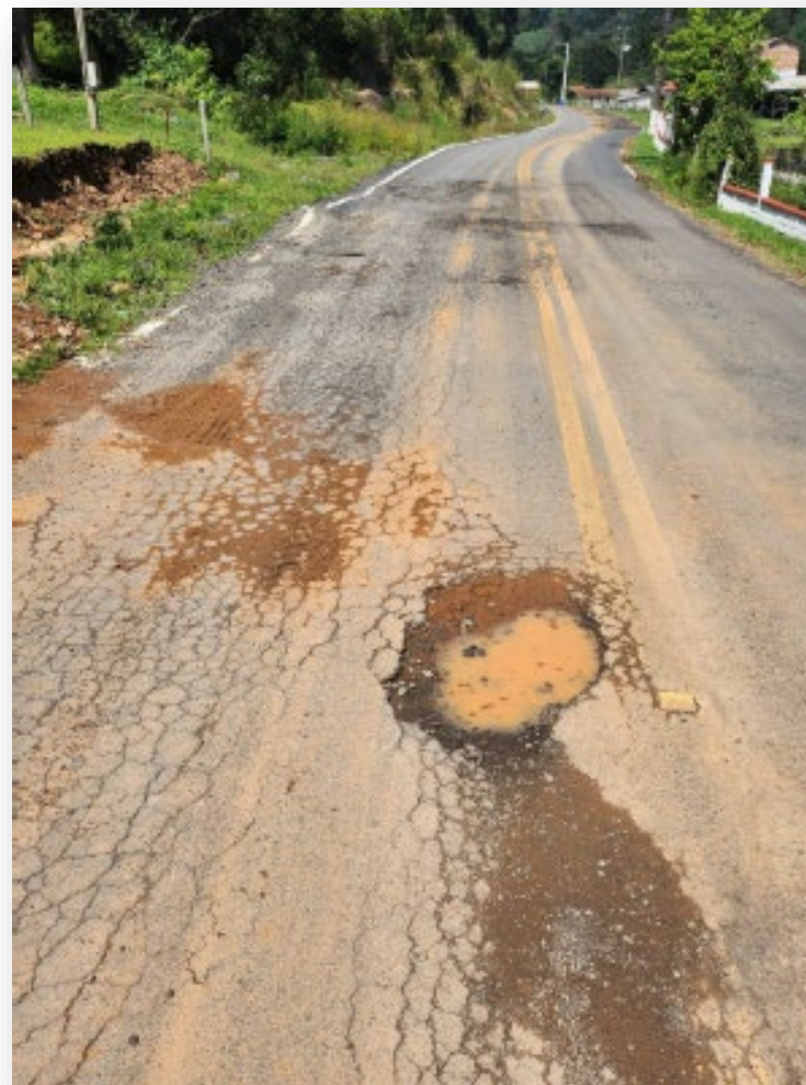
Ausência de drenagem – pavimento com 1 ano
