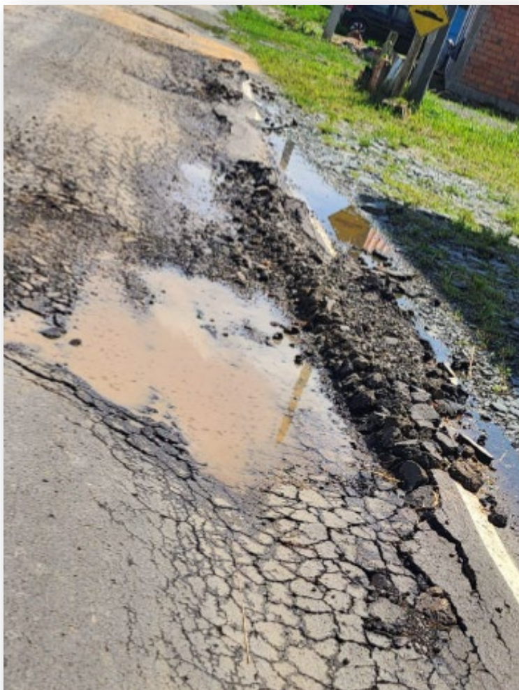
Ausência de drenagem – pavimento com 1 ano
