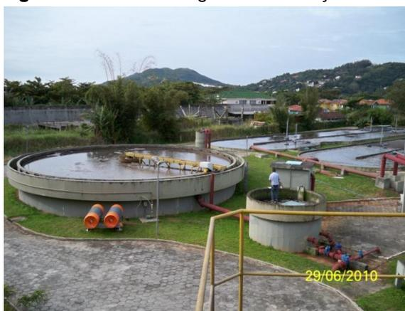
Foto 0327 – cilindros de cloro instalados no decantador
