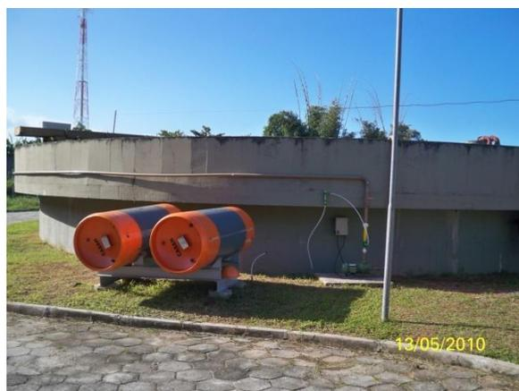
Foto 2443 - cilindros de cloro instalados no decantador
