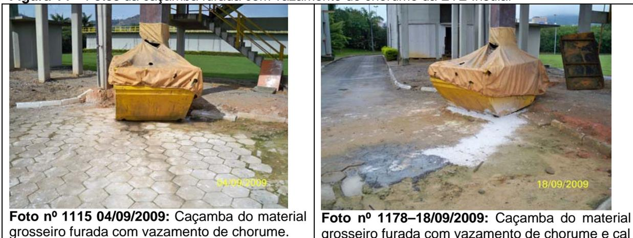
**Foto nº 1115 04/09/2009:** Caçamba do material grosseiro furada com vazamento de chorume.
