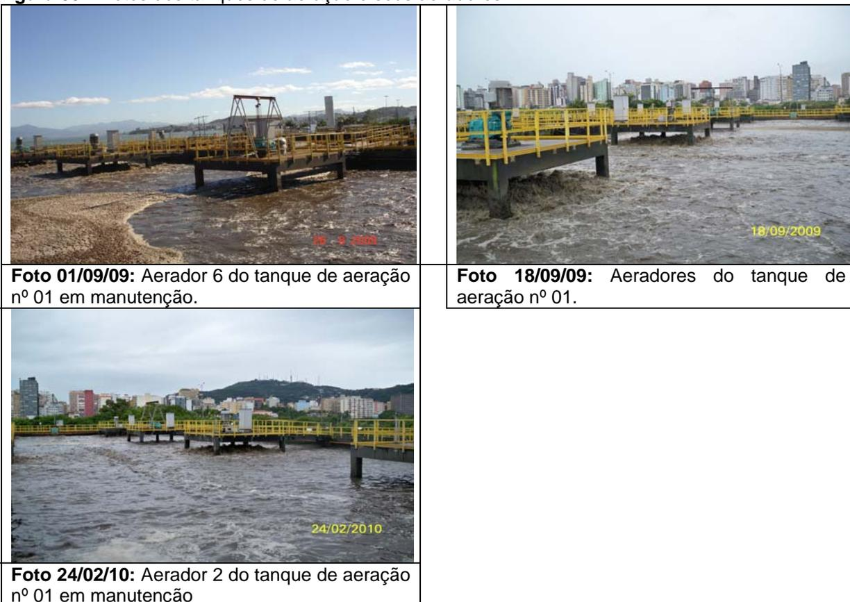
Do exposto, conclui-se que ainda é necessário a Casan realizar a compra e instalação da rosca transportadora para o material grosseiro e o carreamento da água da lavação para a calha parshall. Quanto aos aeradores recomenda-se que a manutenção seja mais rápida. Aguarda-se o próximo relatório da Casan informando as soluções dos casos apontados.
