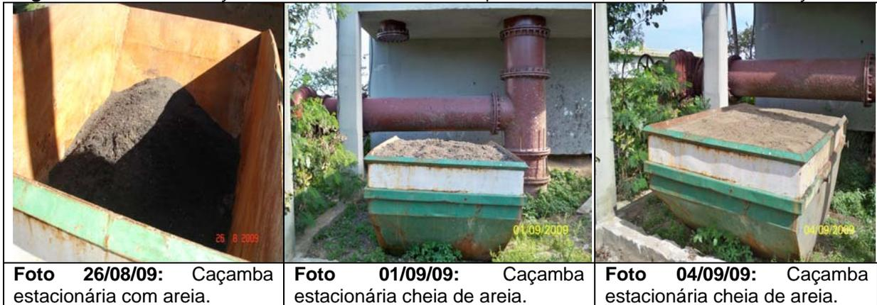
A caçamba estacionária ficou cheia de areia entre os dias 01 e 07/09/09. O BDO do dia 07/09 registra a retirada da areia e a colocação de outra caçamba. No período em que a caçamba estava cheia (7 dias), não ocorreu à retirada de areia do tanque de desarenação, em descumprimento ao critério estabelecido no Manual, ou seja, 2 vezes por dia.
