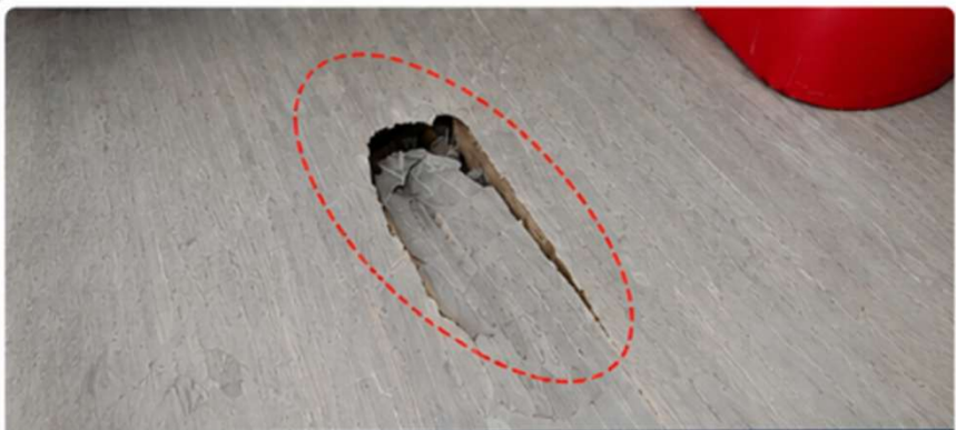
Afundamento localizado do piso
