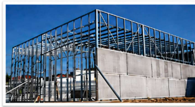
Sistemas construtivos com perfis em aço galvanizado e placas cimentícias (LSF).
