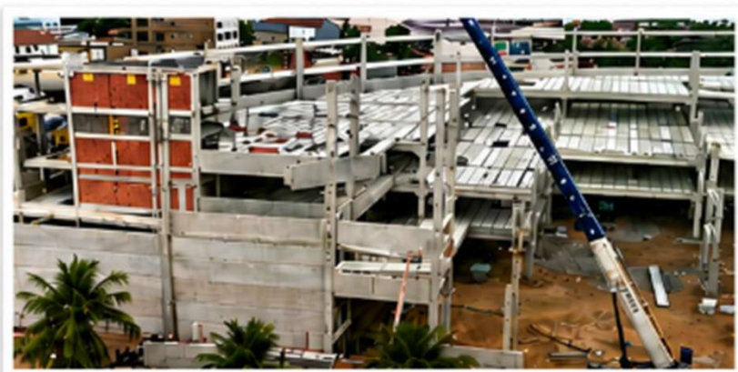
Pré-fabricado de concreto.
