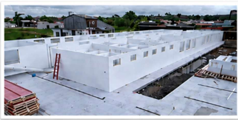
Módulos 2D com painéis metálicos tipo “sanduíche”, fechamento e cobertura.
