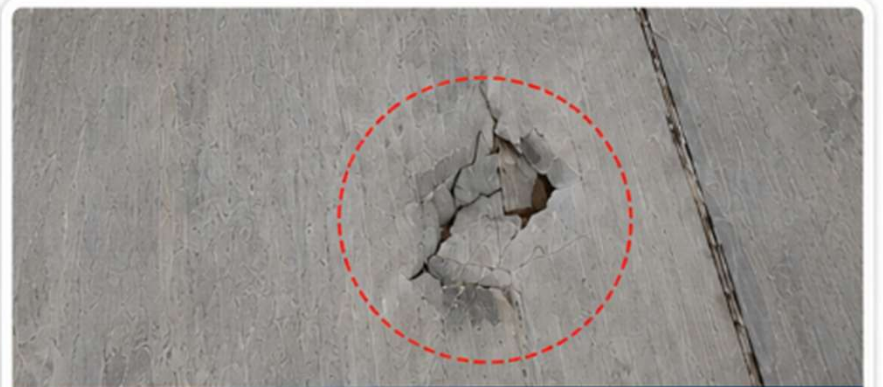
Deformação e afundamento do piso
