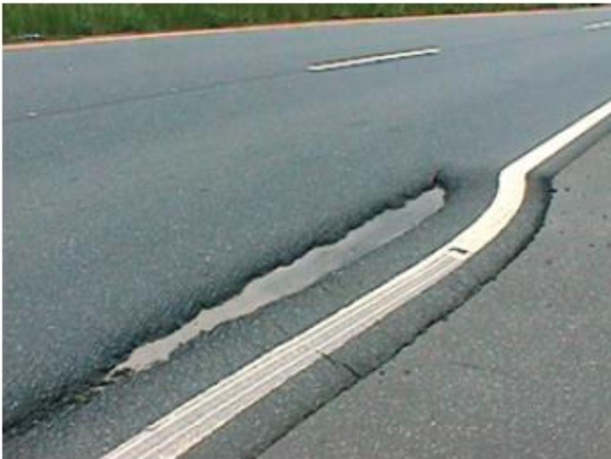
**Escorregamento do revestimento asfáltico por falhas construtivas e de pintura de ligação.**
