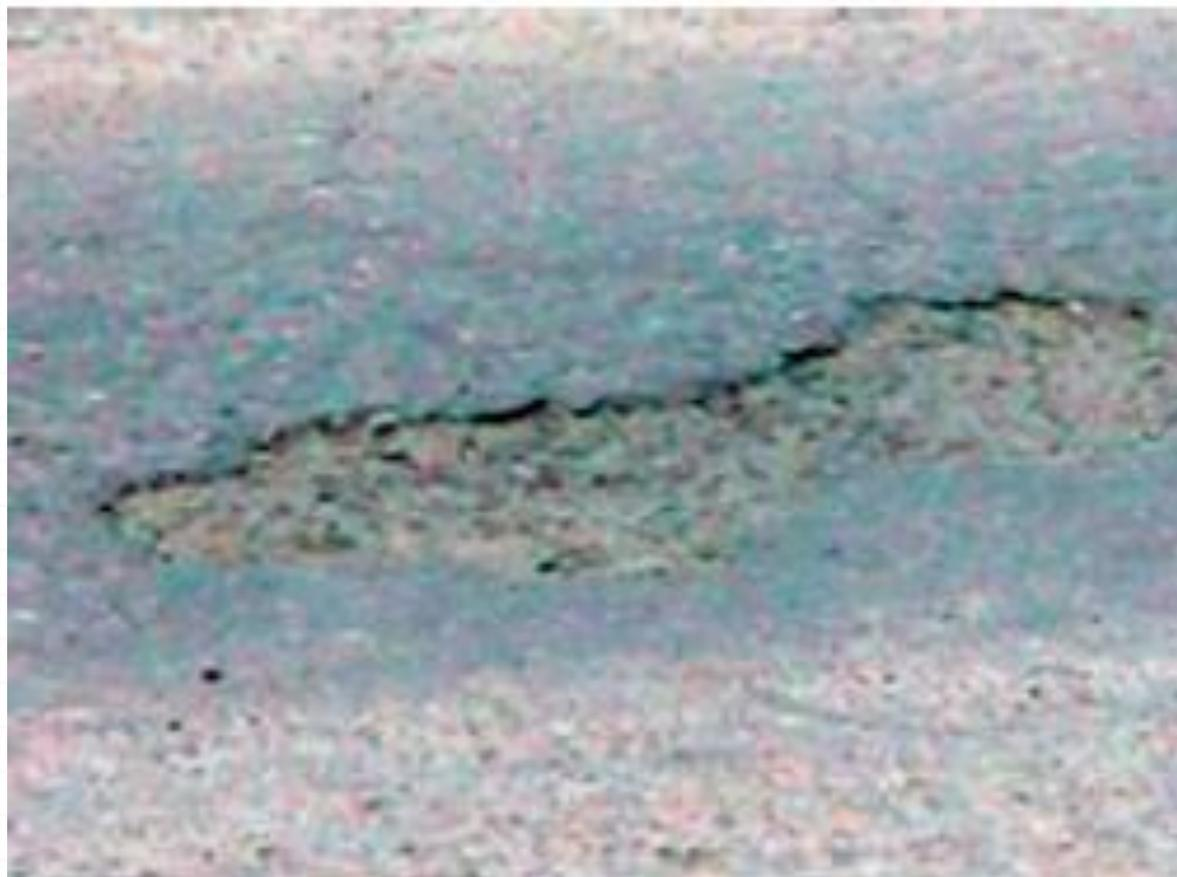
**Falha na pintura de ligação em camadas de revestimento causando o descolamento.**
