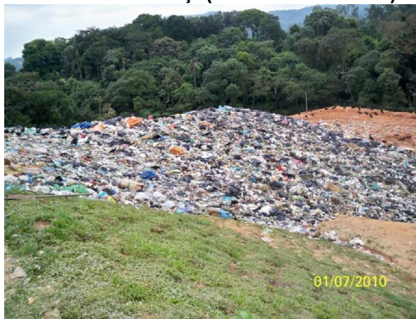
Foto 5 - Frente de Serviço (Resíduos sem cobertura)
