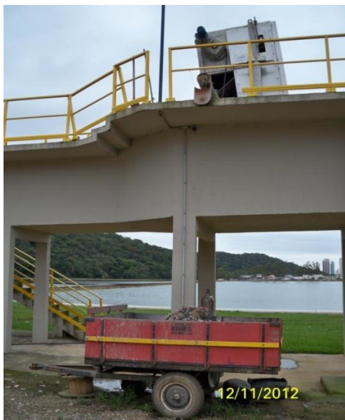
Foto nº 1504 de 12/11/12 – Material grossoiro colocado em carroceria com vasamento de líquido percolado.
