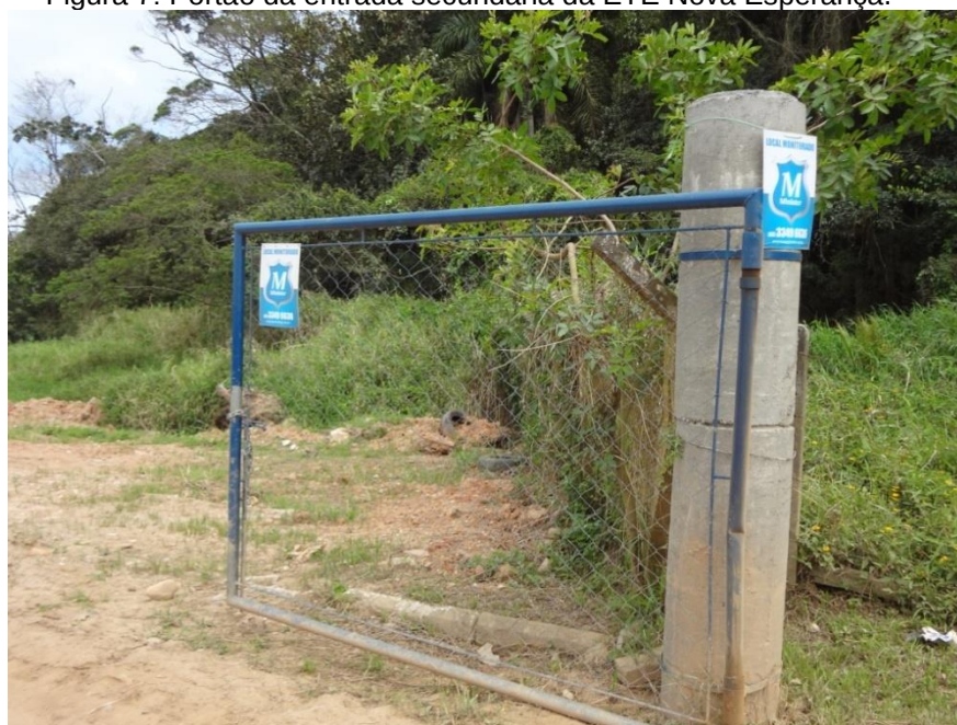
Figura 8: Portão da entrada secundária da ETE Nova Esperança.
