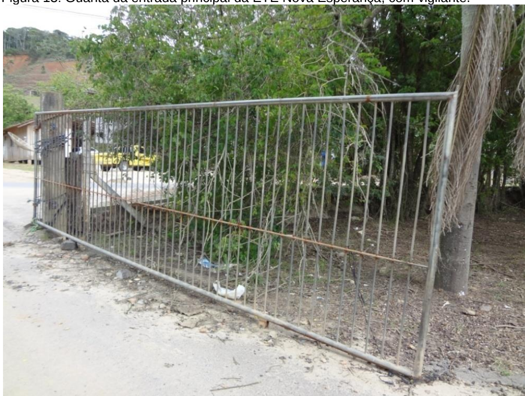
Figura 14: Portão da entrada principal da ETE Nova Esperança.
