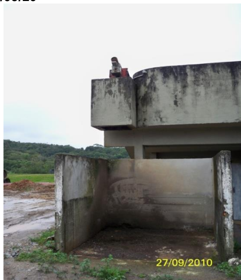
Foto nº 1210 de 27/09/10 - Local onde a areia cai antes de ser retirada.
