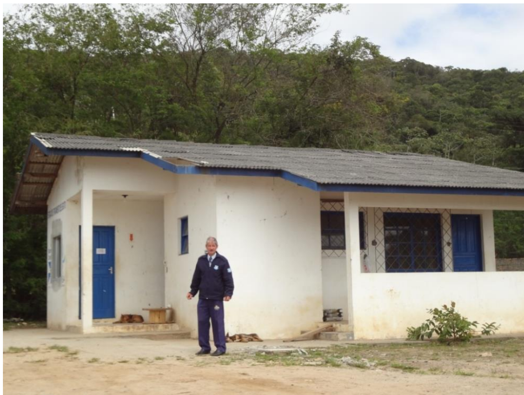
Figura 13: Guarita da entrada principal da ETE Nova Esperança, com vigilante.
