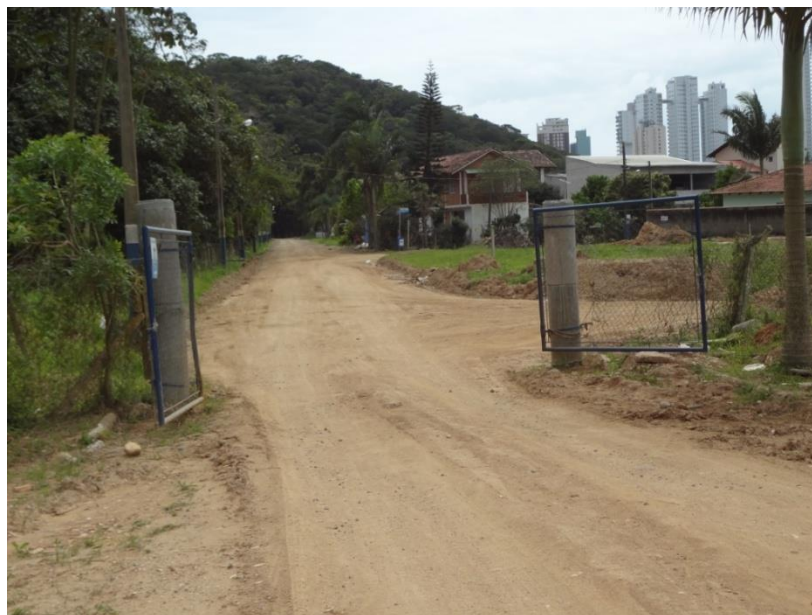
Figura 7: Portão da entrada secundária da ETE Nova Esperança.
