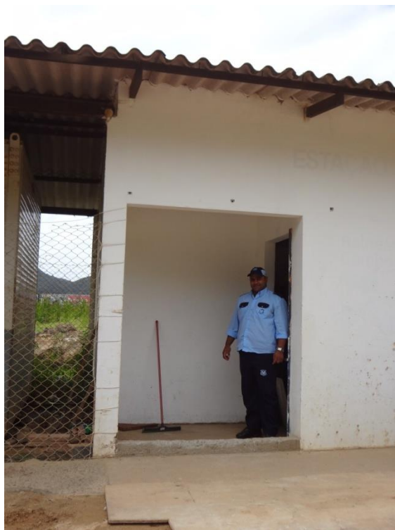
Figura 9: Guarita da entrada secundária da ETE com o vigilante.
