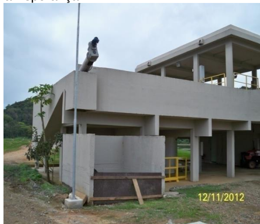
Foto nº 1555 de 12/11/12 – areia em compartimento esquerdo junto ao conjunto da calha parshall.
