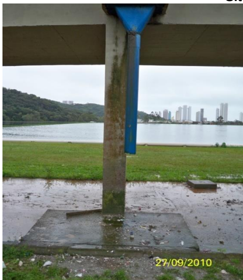
Foto nº 1203 de 27/09/10 – Local de lançamento do material grosseiro antes de ser retirado pelo operador da ETE Nova Esperança.
