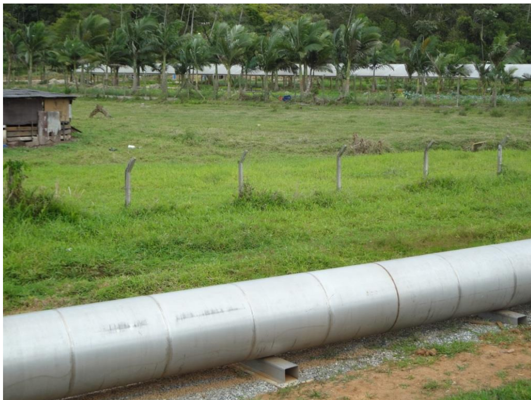
Figura 11: Isolamento da área da ETE Nova Esperança, próximo à lagoa de aeração.
