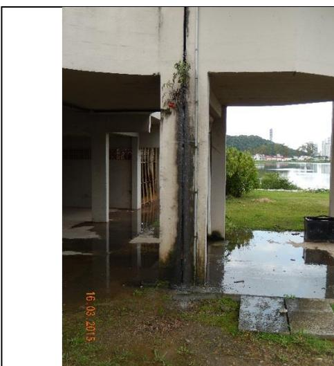
Foto nº 0641 de 16/03/2015 TCE – vazamento de esgoto pela junta de dilatação do pré-tratamento
