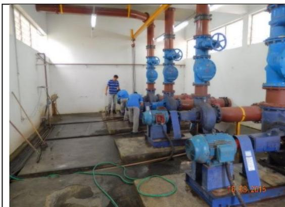
**Foto nº 0706 de 16/03/2015 TCE** – manutenção das bombas de recirculação de lodo, depois de ocorrer o extravasamento de lodo no decantador nº 01.
