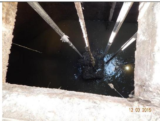
Foto nº 0484 de 12/03/2015 TCE – com sexto cheio de resíduos sólidos sem a devida limpeza. A falta de limpeza das elevatórias estraga as bombas.
