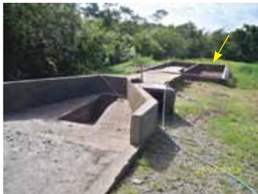
Leito de secagem do material dos limpa-fossas sem cobertura e proteção
