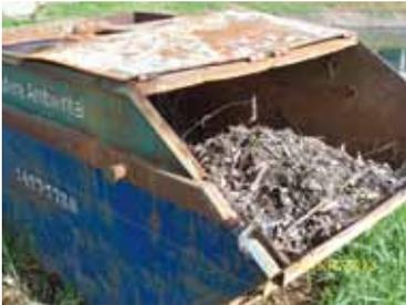
Caçamba com material retirado da caixa de entrada do esgoto na Estação — espuma e sobrenadantes — no dia 27/02/2013
