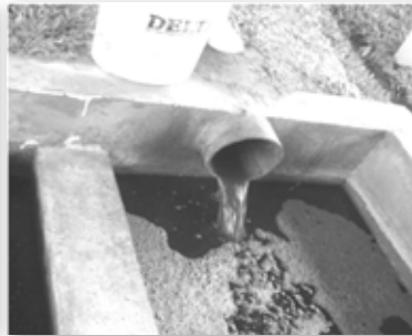
FIGURA 2 | Sistema de tratamento de efluente (líquidos percolados)
