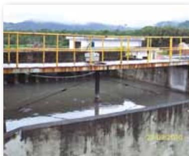
Foto nº 1.201 de 27/09/2010 — Raspador esquerdo do tanque de desarenação em atividade na ETE Nova Esperança
