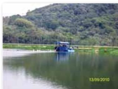
Foto nº 1.452, de 13/09/2010 — Lagoa de estabilização (anaeróbica) da ETE Nova Esperança desativada e em processo de drenagem
