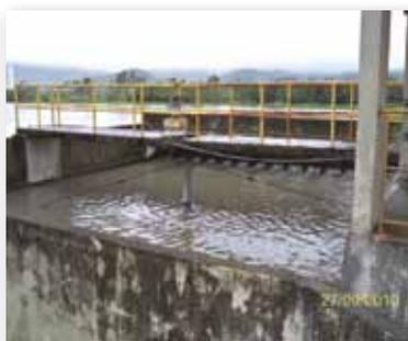
Foto nº 1.198 de 27/09/2010 — Raspador direito do tanque de desarenação avariado na ETE Nova Esperança
