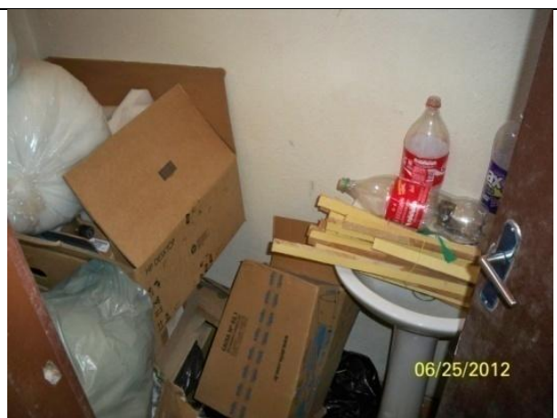
Foto 100_5045: Banheiro utilizado como depósito.
