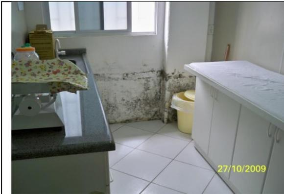
Foto triagem (2): infiltração na sala de triagem da UBS de Rio Grande.
