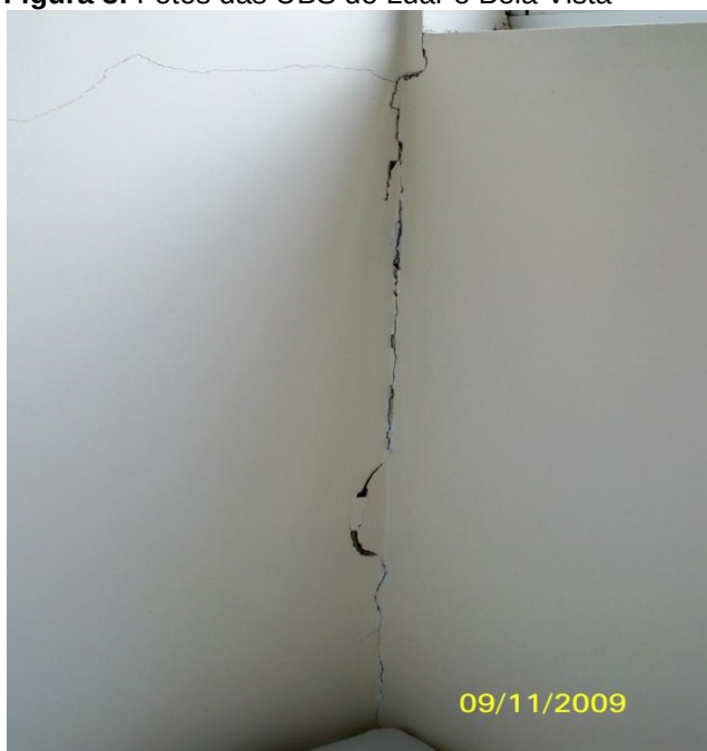
UBS de Luar – rachadura na sala de curativo
