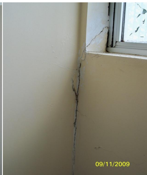
UBS de Luar – rachadura na sala de curativo
