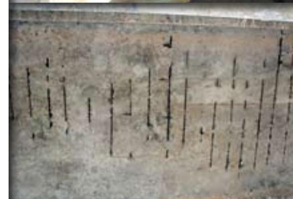
REALIDADE | armadura principal de uma das vigas da ponte sobre o canal da Barra pode se romper
