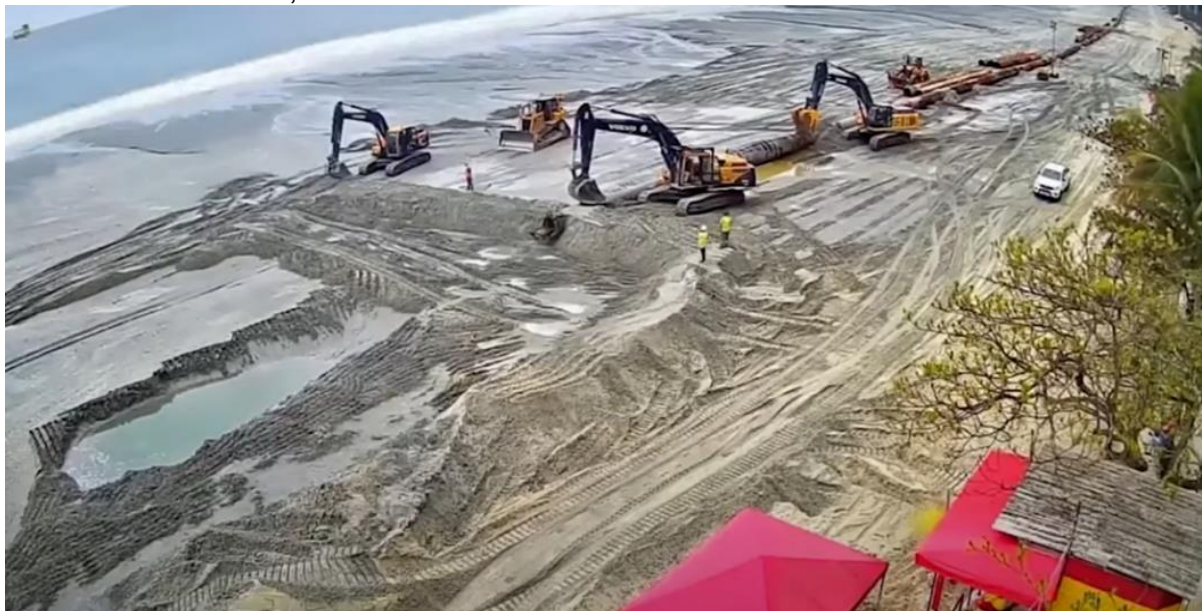
Figura 11 – Captura de imagem em vídeo que evidencia a patrulha de equipamentos em operação no espalhamento de material na faixa de areia da Praia Central de Balneário Camboriú, em 2021 11
