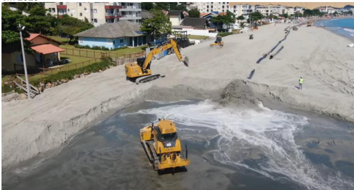
Figura 12 – Captura de imagem em vídeo que evidencia a patrulha de equipamentos em operação no espalhamento de material na faixa de areia da Praia dos Ingleses, em 2023 12
