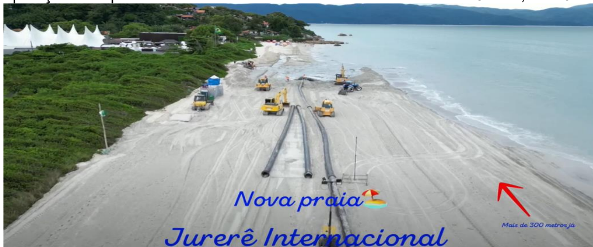
Figura 13 – Captura imagem em vídeo que evidencia a patrulha de equipamentos em operação no espalhamento de material na faixa de areia da Praia de Jurerê, em 2024 13
