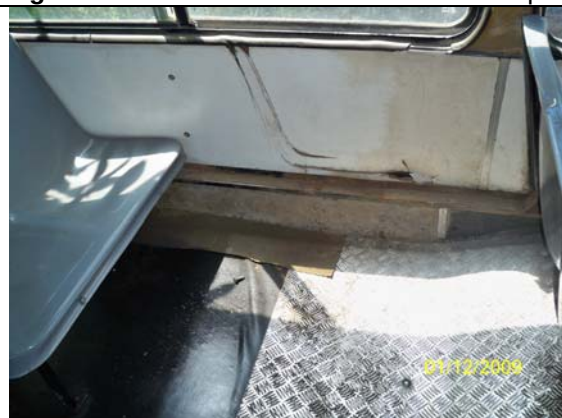
Foto 23 em 01/12/2009 – chapa no assoalho para tampar rachadura.
