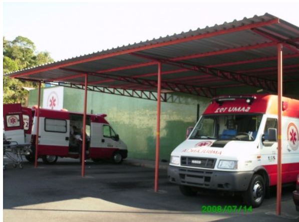
Figura 26: Garagem coberta para ambulâncias da CR de Joinville
