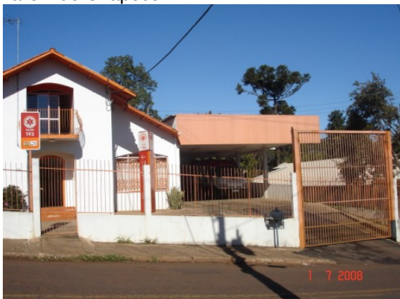
Figura 19: Portão de acesso das ambulâncias na CR de Chapecó
