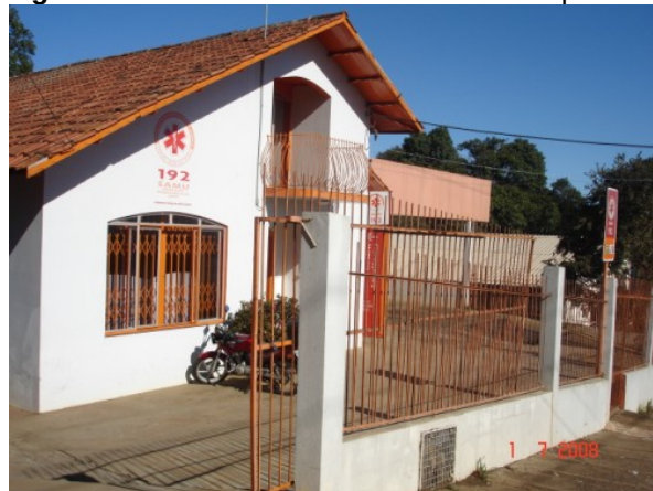
Figura 32: Portão de acesso à CR de Chapecó
