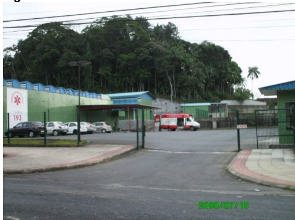
Figura 31: Portão de acesso à CR de Joinville
